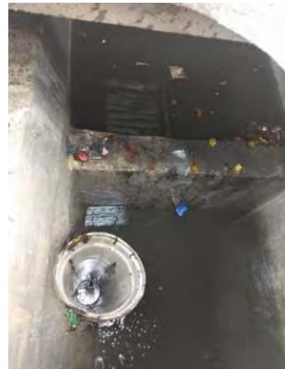
Inundación por vados y deficiencia constructiva de pozo de absorción.
