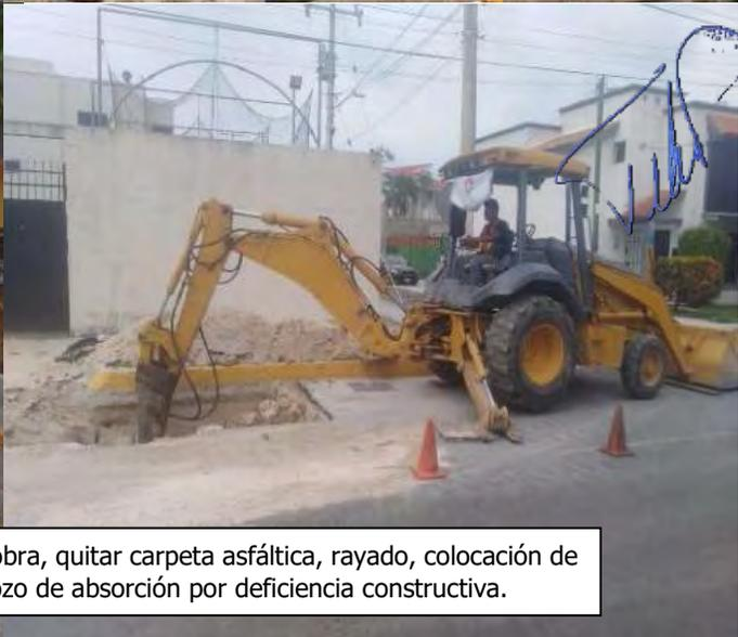
Diferentes aspectos del inicio de la obra, quitar carpeta asfáltica, rayado, colocación de nueva carpeta asfáltica, retrabajo de pozo de absorción por deficiencia constructiva.
