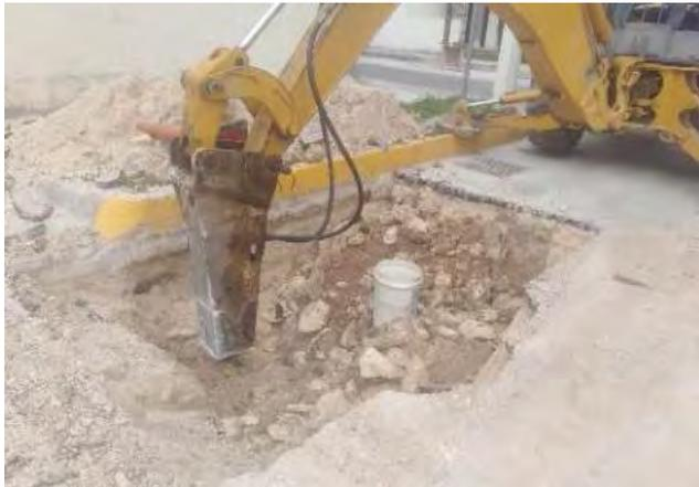
Retrabajos del pozo de absorción mal construido causante de inundaciones y cruce de línea de agua potable, ya terminado el reencarpetamiento asfáltico reportado por el comité contralor social.
