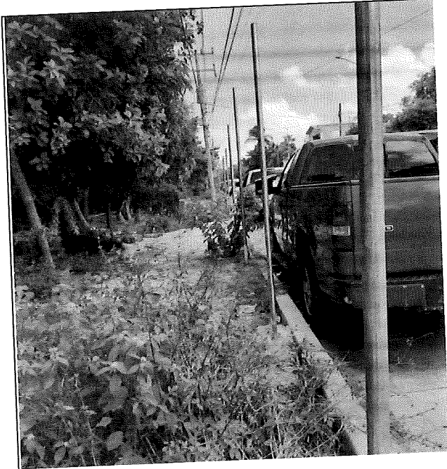
Figura 1. Colocación de tubos en perímetro del ANP para colocación de malla.
