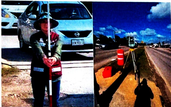
Levantamientos topográficos de la intersección.
