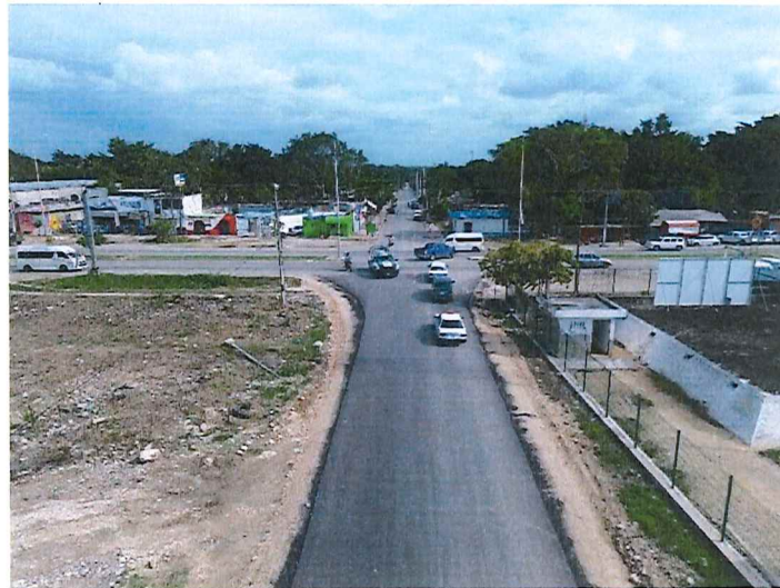
Figura 10. Foto aérea para la Sección D-D' después de la intersección.
