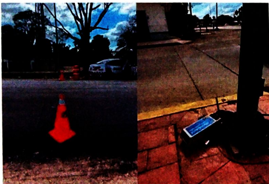
Instalación de contadores automáticos.
